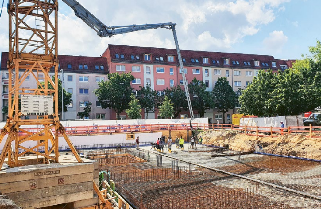
Guss der Bodenplatte
