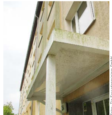
Fotos: Die Fassadenreiner GmbH
